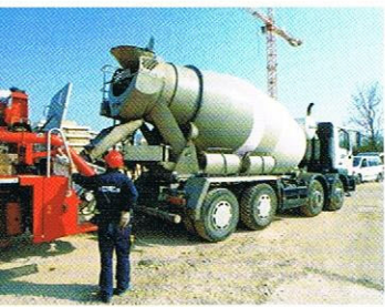
Strenge Kontrollen und Produktsteuerung sorgen für konstant hohe Qualität
